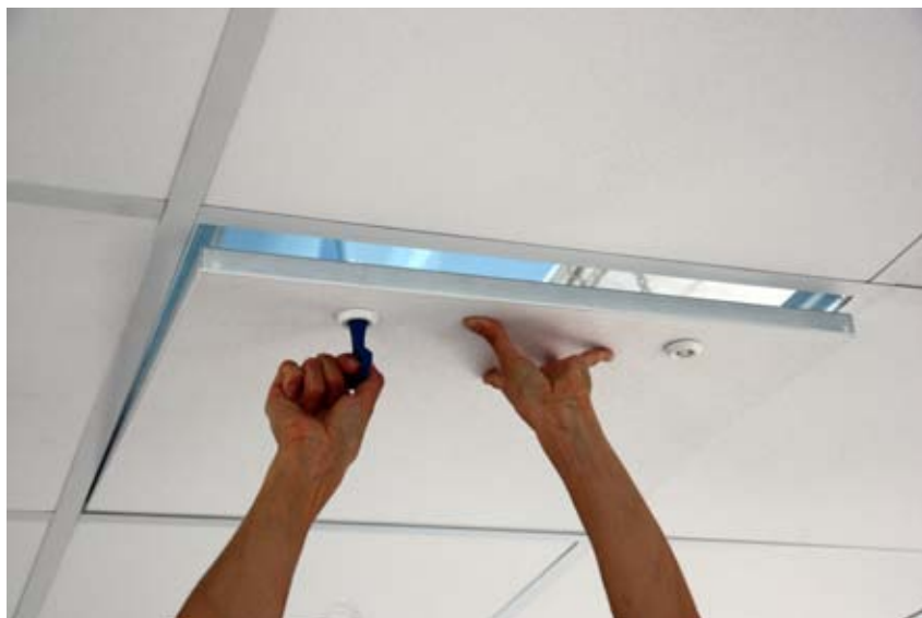
Jednolita powierzchnia sufitu i łatwe otwieranie włazu
